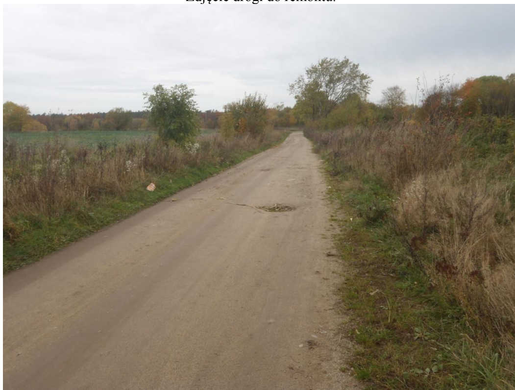
Zdjęcie drogi do remontu.
