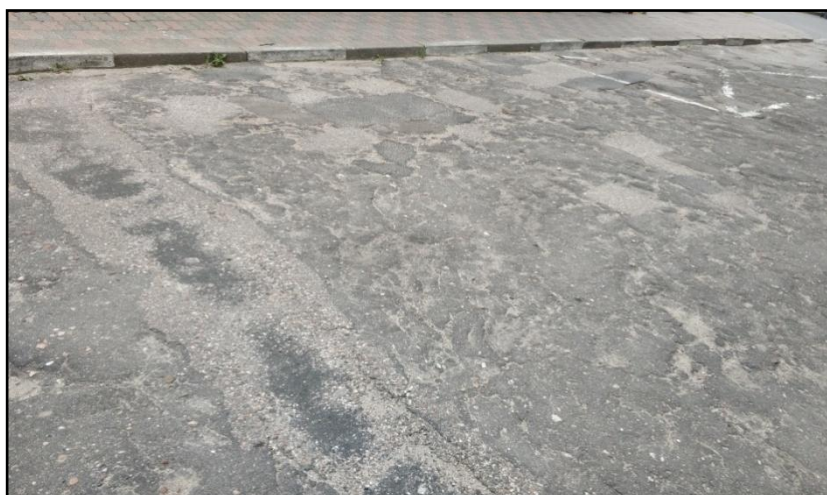
Rys. nr 2 Fragment drogi nr 147026Z, nawierzchnia bitumiczna.
