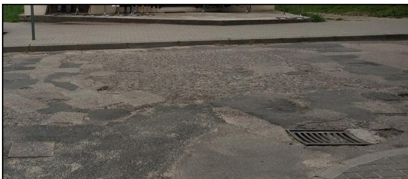
Rys. nr 1 Jedna ze studzienek wymagająca wymiany i regulacji.
