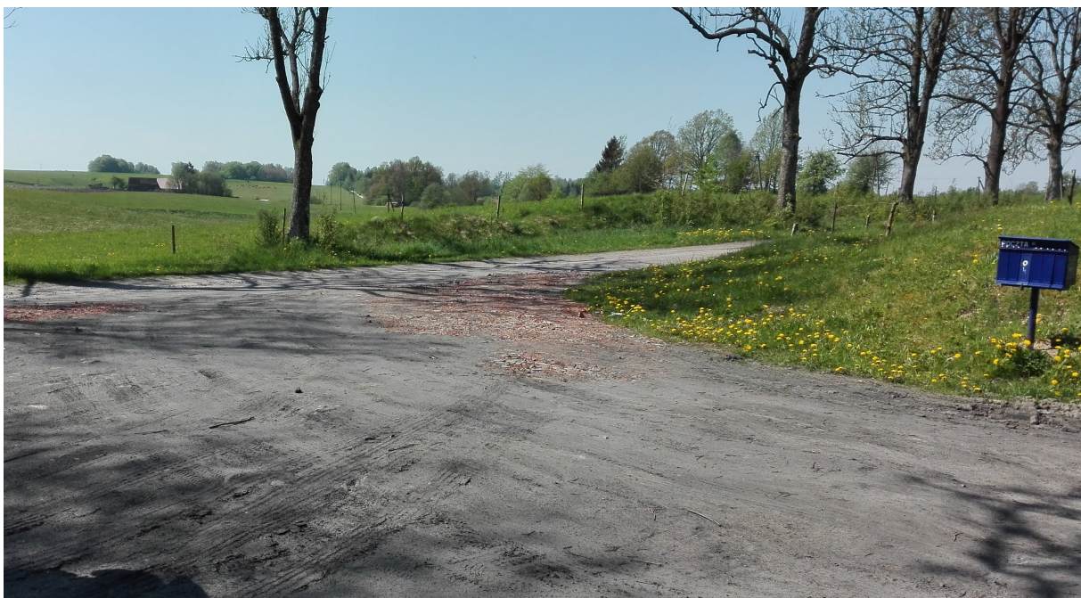
Rys. nr 1 - Fragment drogi nr 146026 Z w km 1+ 316,41
