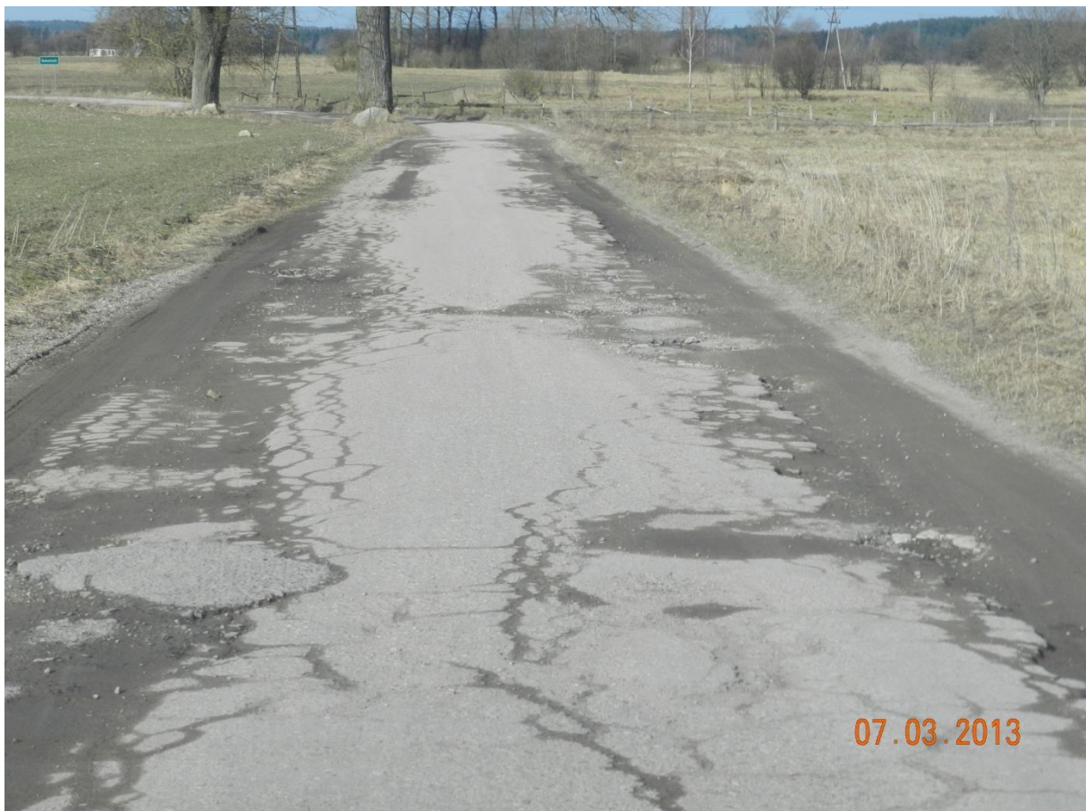
Fragment drogi nr 146015 Z, nawierzchnia bitumiczna ok. 0+230 km drogi.
