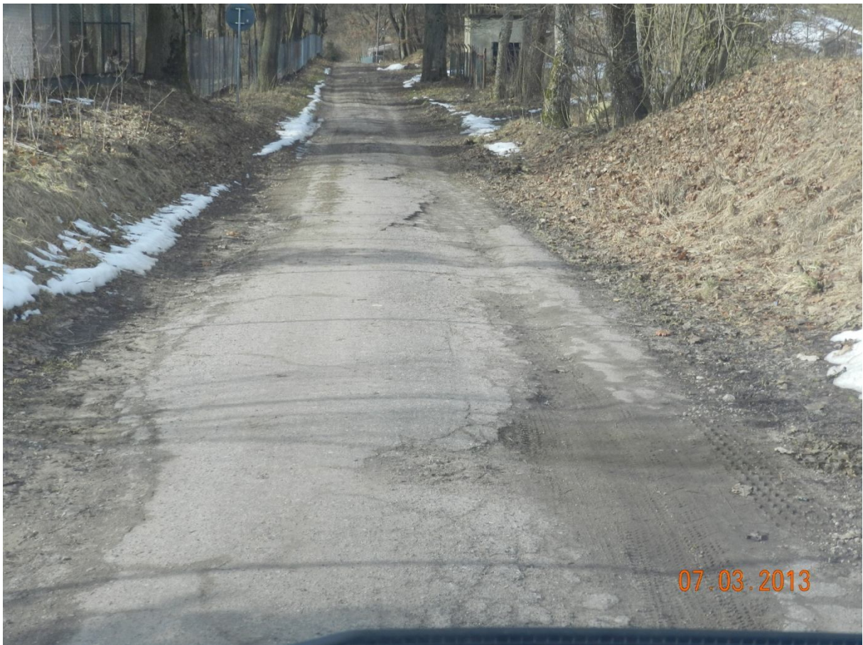
Fragment drogi nr 146015 Z, nawierzchnia bitumiczna ok. 1+030 km drogi
