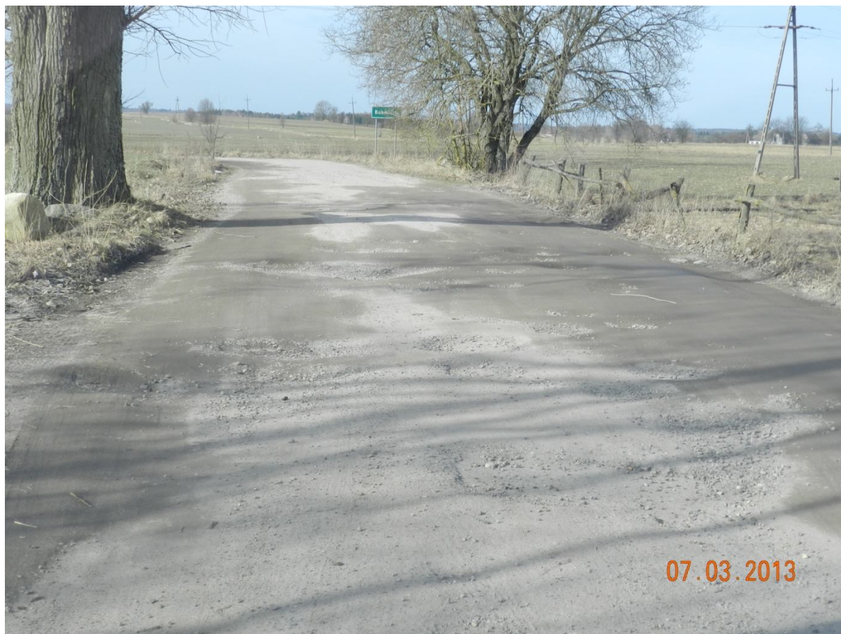
Fragment drogi nr 146015 Z, nawierzchnia bitumiczna ok. 0+300 km drogi.
