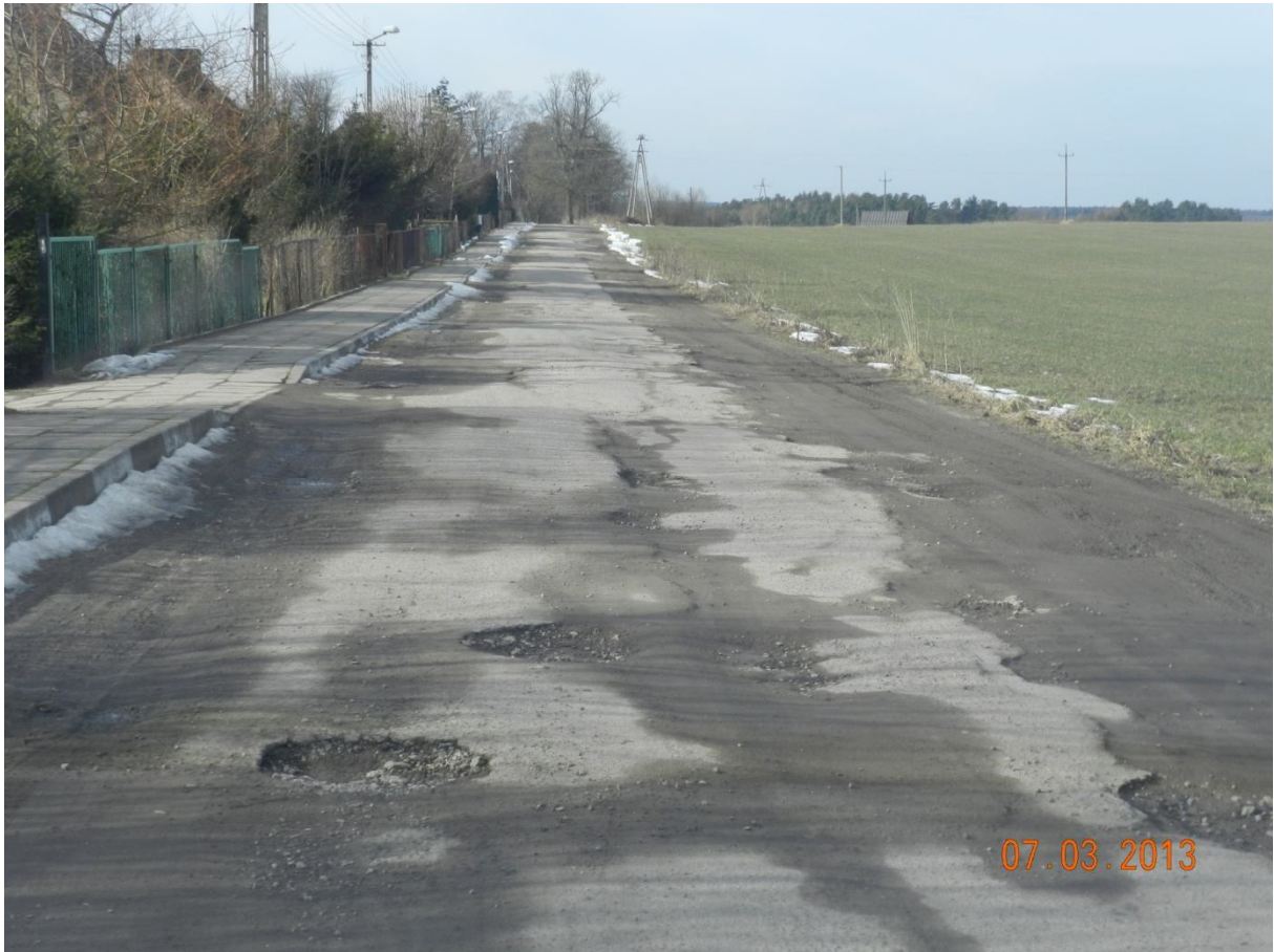
Fragment drogi nr 146015 Z, nawierzchnia bitumiczna ok. 0+670 km drogi.
