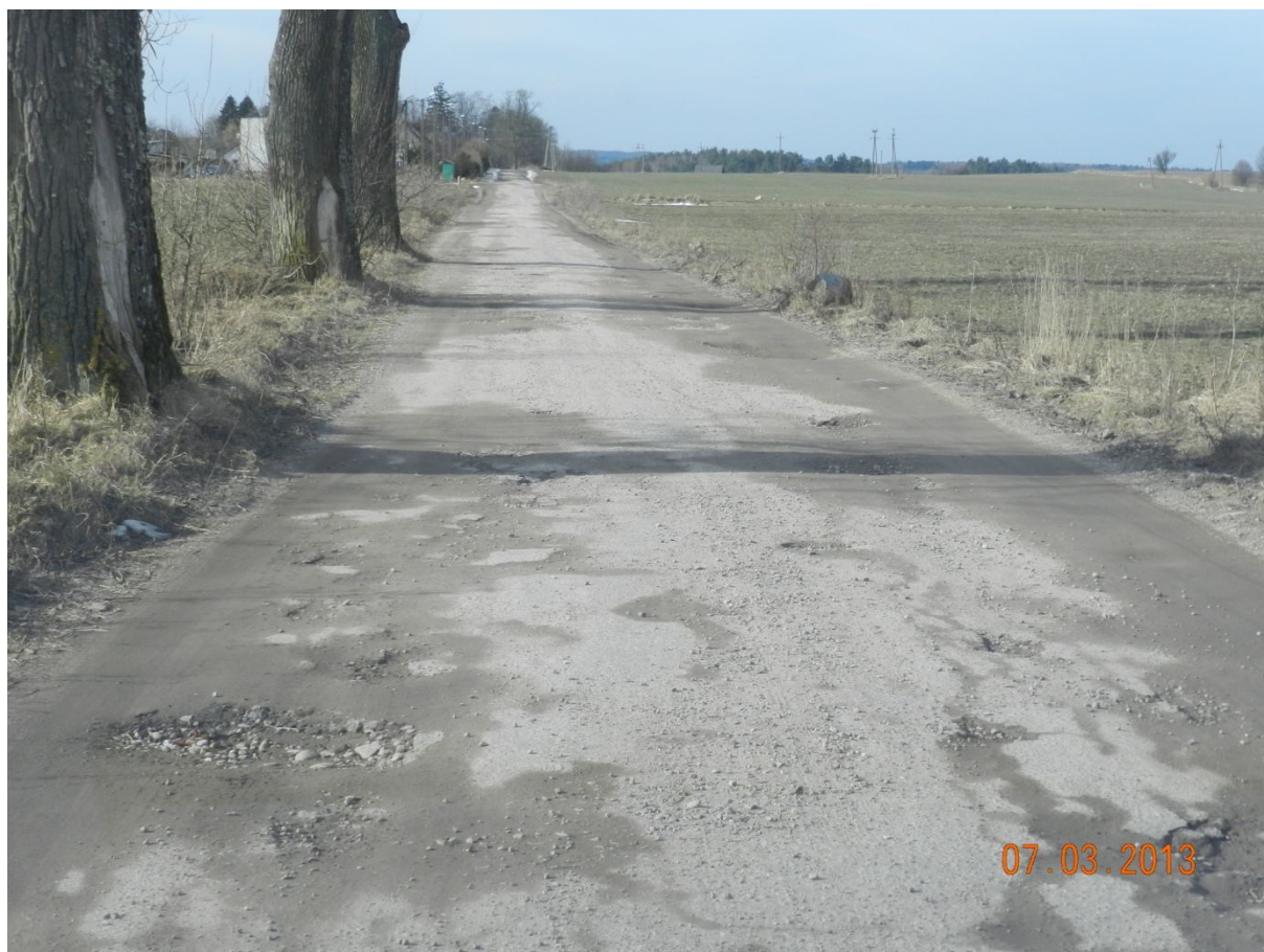
Fragment drogi nr 146015 Z, nawierzchnia bitumiczna ok. 0+400 km drogi.
