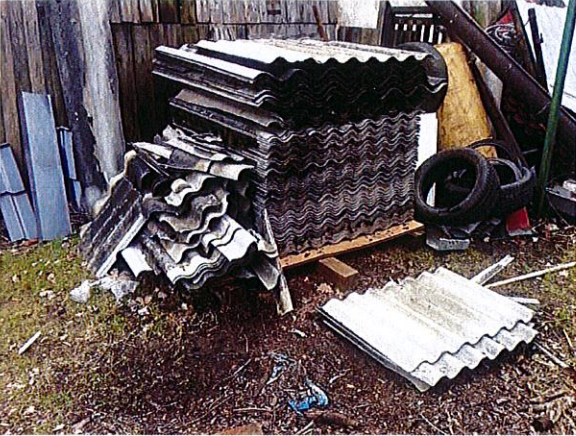
14. Budynek gospodarczy, Chociwle 7/5, 76-020 Bobolice, Dz. nr 75/1 obr. Chociwle – demontaż.
