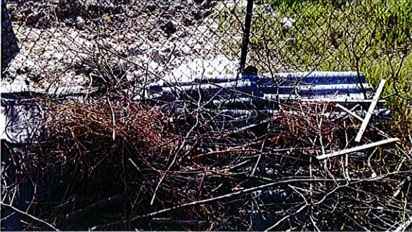
27. Budynek gospodarczy, Różany 2/1, 76-020 Bobolice, Dz. nr 3/3, obr. Różany – odbiór.
