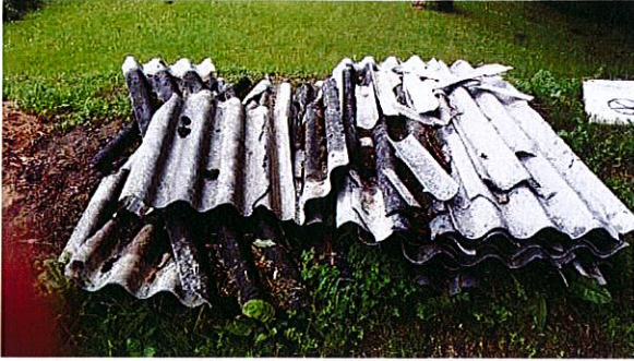
18. Budynek mieszkalny, Dobrociechy 14/1, 76-020 Bobolice, Dz. nr 2/13 obr. Dobrociechy – Demontaż.
