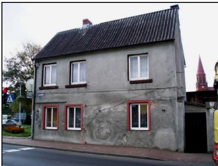
Fot. Budynek mieszkalny pokryty eternitem
