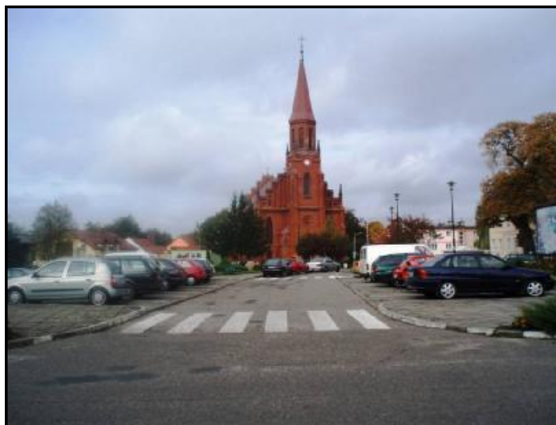
For. Rynek bobolicki – przykład złego stanu nawierzchni dróg
