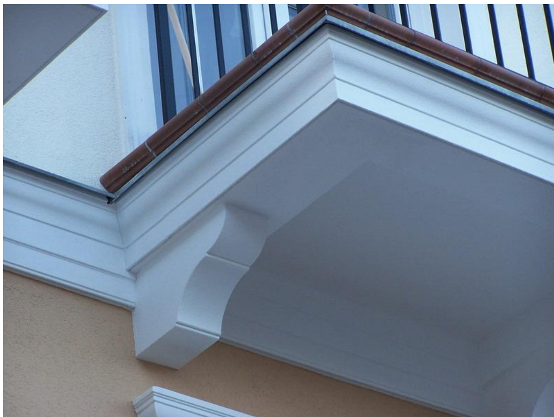
Zdjęcie nr 3 – Balkon – płyta spocznikowa.
