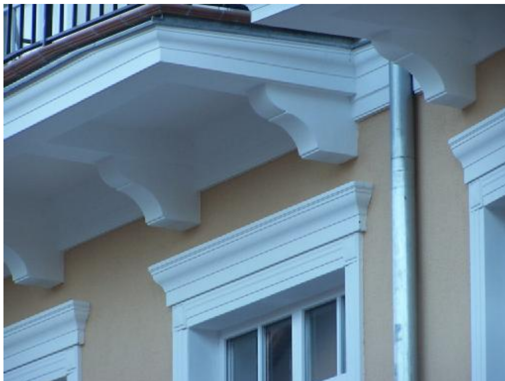
Zdjęcie nr 6 – Widok elewacji.
