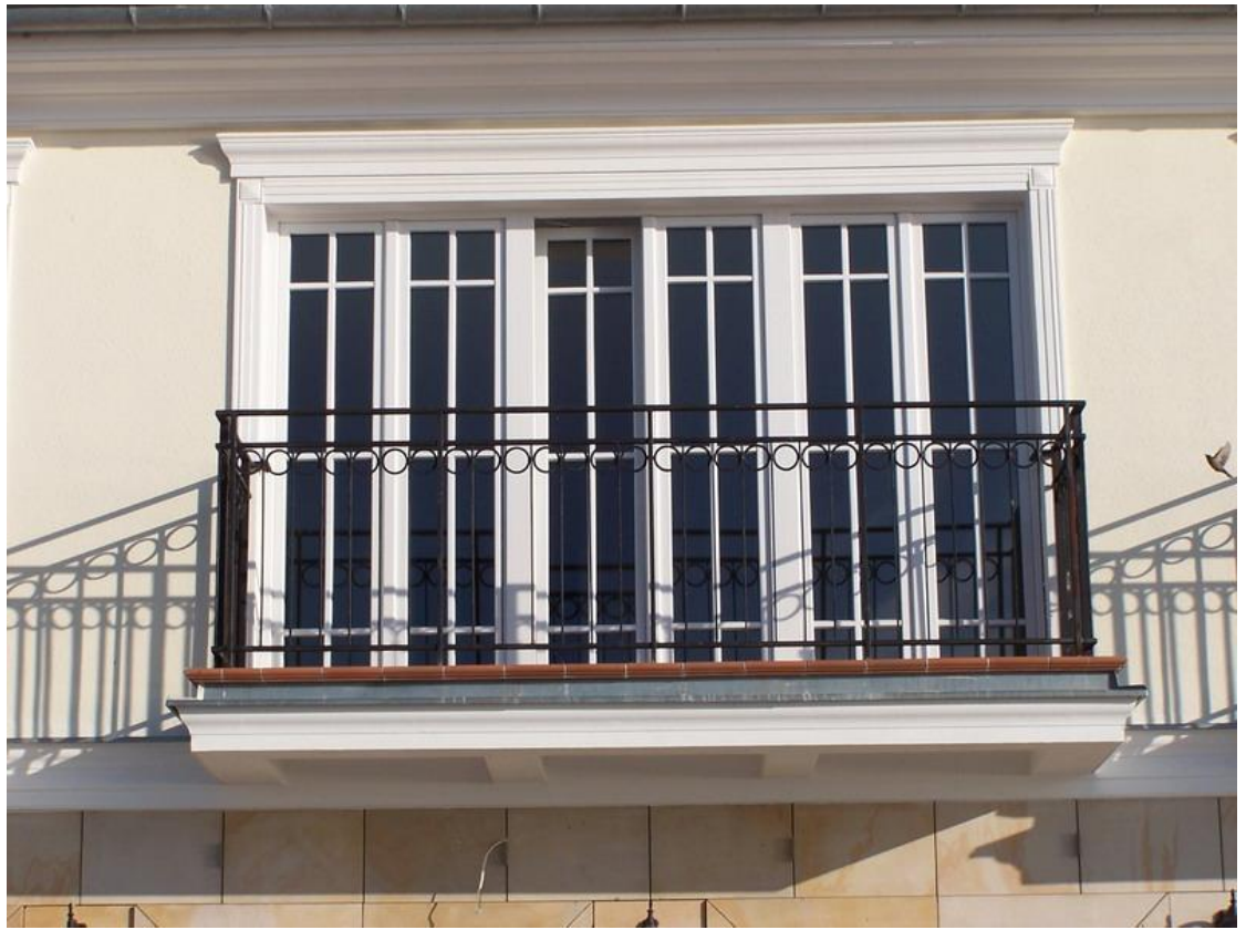
Zdjęcie nr 5 – Widok elewacji.
