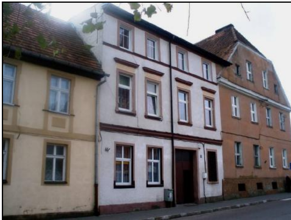
Fot. Stare kamienice w Bobolicach
